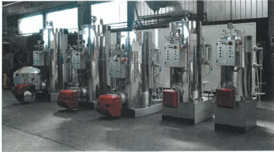
Ceci est le résultat de l'union d'une moderne structure chaudière avec un efficient récupérateur / surchauffeur – accumulateur de vapeur, qui, grâce au système amélioré, récupère l'énergie résiduelle des fumées, en l'employant pour sécher et surchauffer la vapeur.
